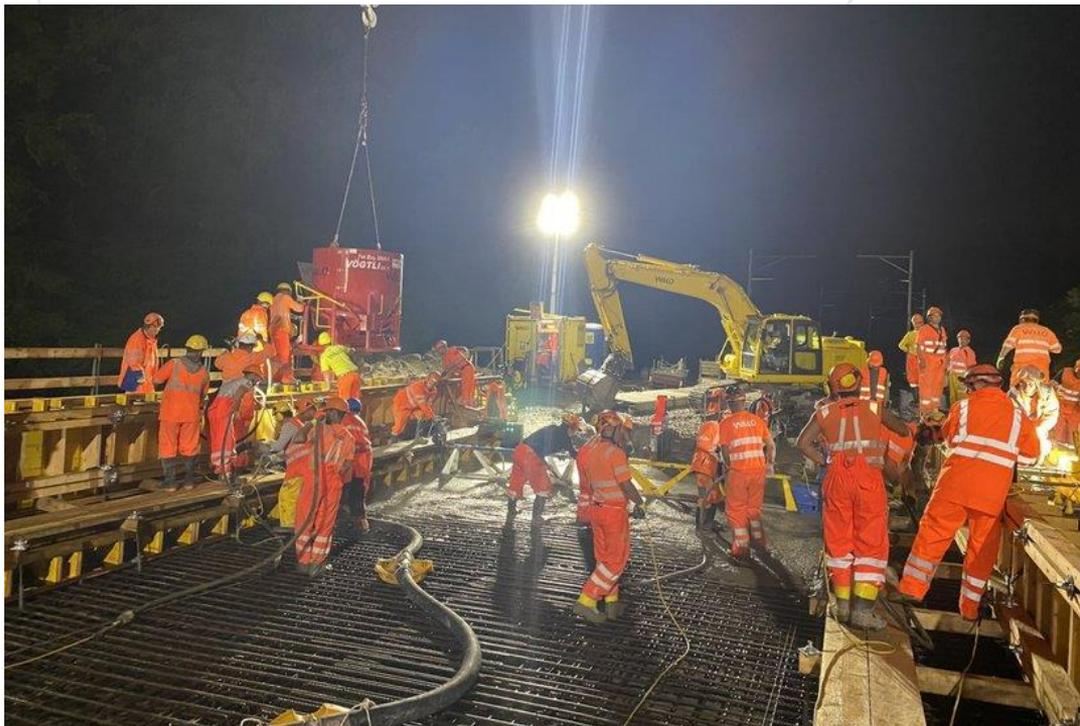
Le béton a été livré en deux consistances différentes pour être pompé ou mis en œuvre à l'aide d'une grue.
