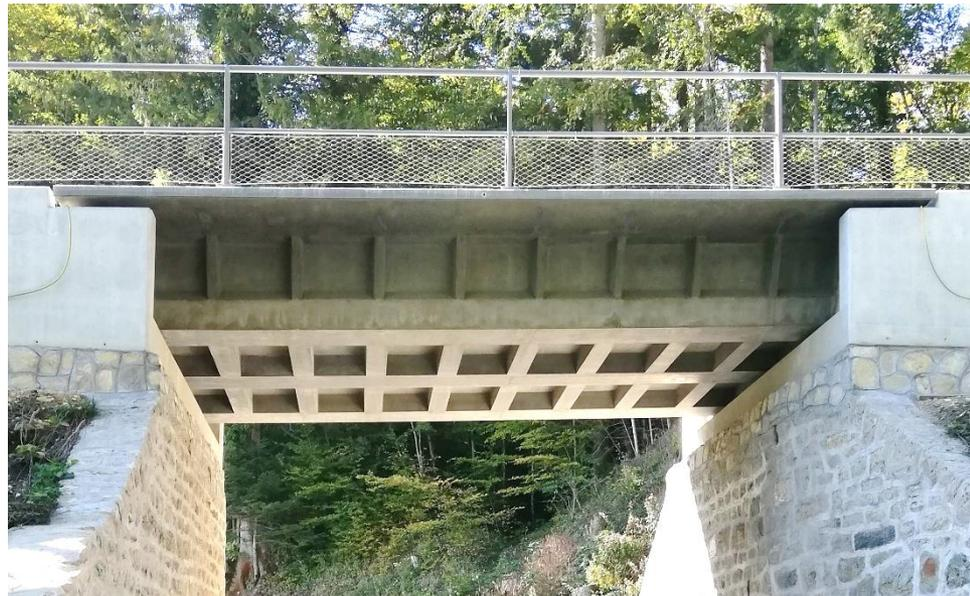
*PI de l'Aiguillon (1er pont ferroviaire entièrement en CFUP)*
