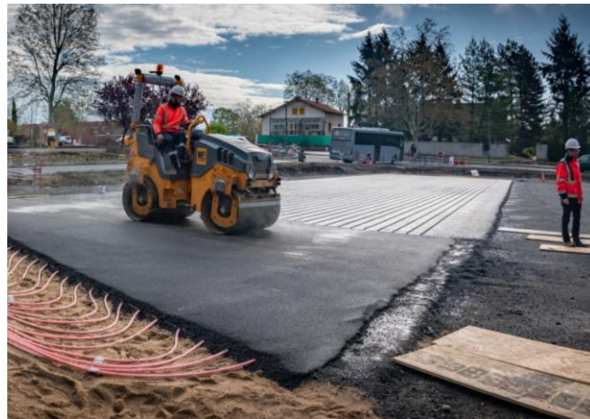
Des tubes sous la couche de roulement
