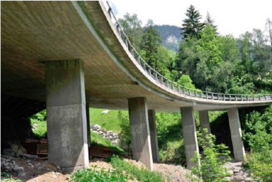
**Pont-dalle massive en béton armé, (1969) longueur: 78m**
