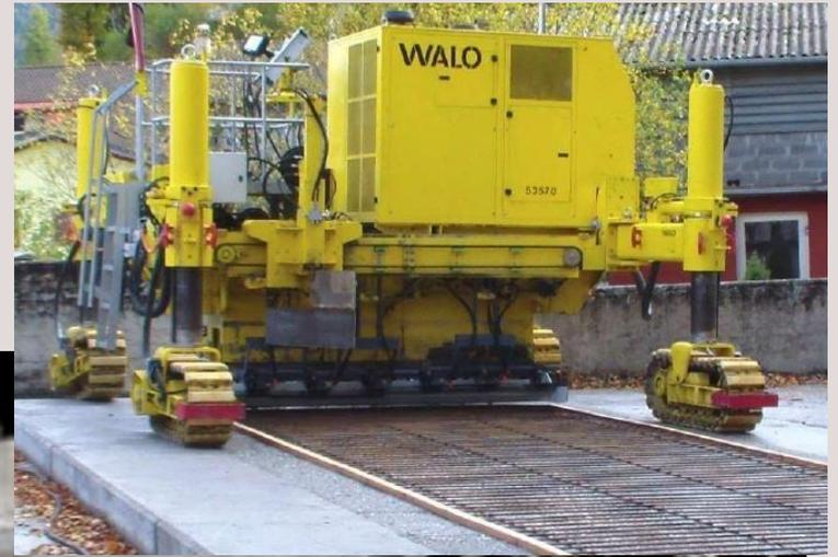
Des essais de mise en place du BFUP de façon automatisée avec une finisseuse ont été réalisés avec succès.
